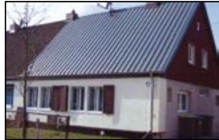
Nachher: Passgenaue Dacheindeckung auf bestehendes Pfannenprofil
