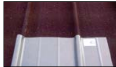
Nachher: Passgenaue Dacheindeckung auf bestehendes Pfannenprofil
